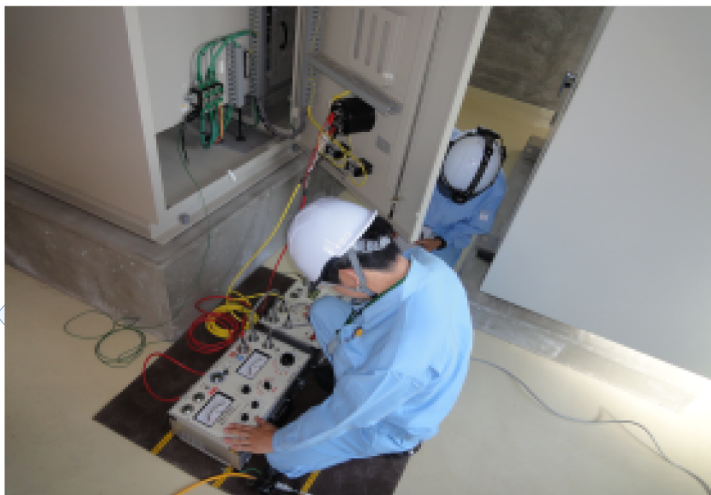
●キュービクルなどの定期点検
