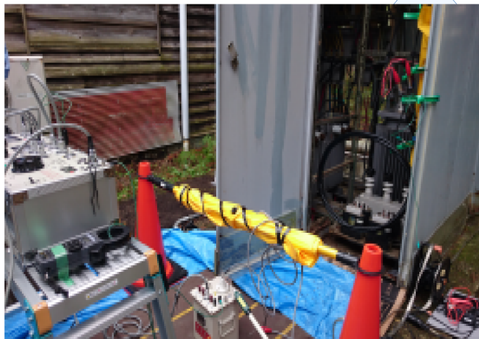
●高圧ケーブル絶縁耐力試験
